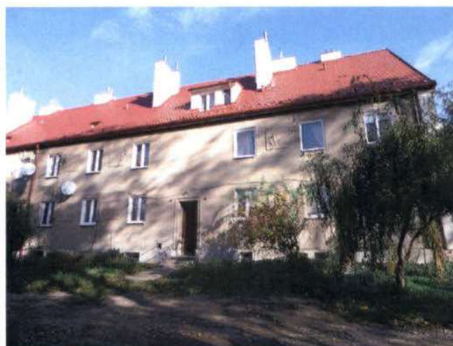
Widok na budynek od strony południowej.
